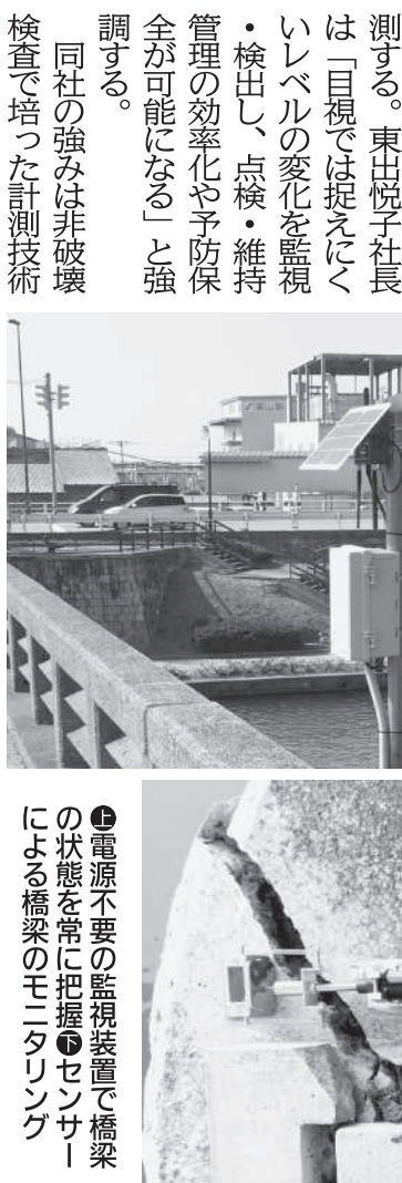
●電源不要の監視装置で橋梁の状態を常に把握。センサーによる橋梁のモニタリング
