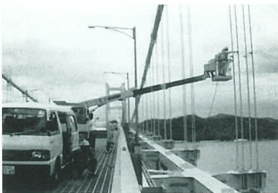
写真9 吊橋のハンガーロープの張力測定
